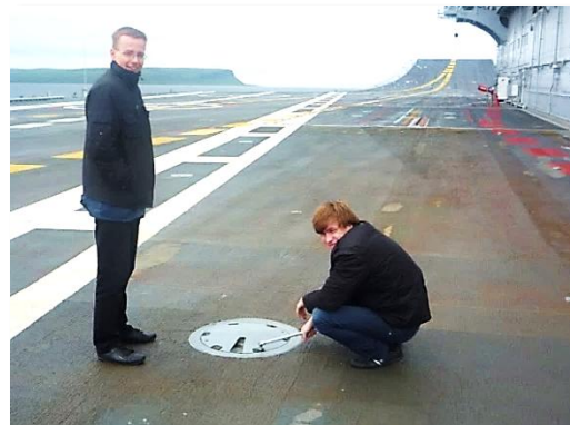
В. Ю. Ушанов, А. И. Мельников. Монтаж телекамеры в палубу индийского авианосца «Викрамадитья»
